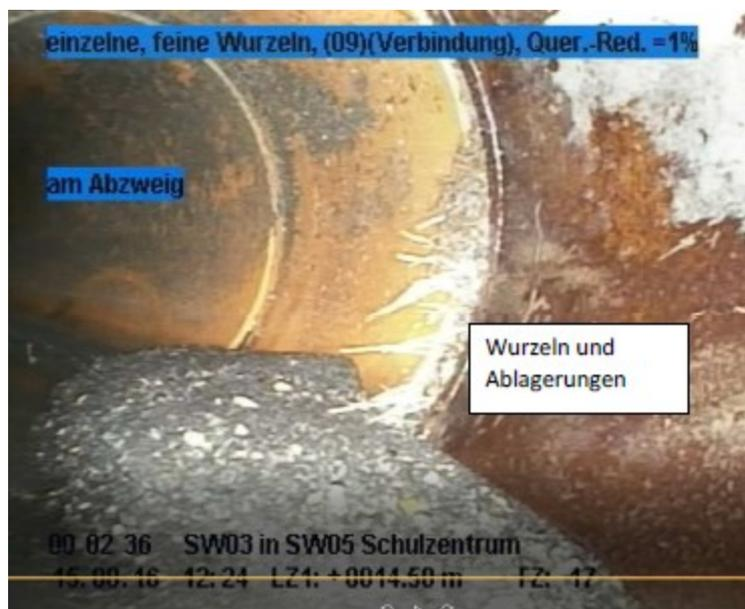
Durch die Verformungen kommt es bei den Rohrübergängen zu Einwüchsen und Schmutzwasser kann ins Erdreich eindringen. Durch die stehenden Wasserstände in den Unterbögen und den Wurzeleinwüchsen kommt es zu Verstopfungen, die in vergangenen Jahren regelmäßig auftraten und beseitigt werden mussten.
