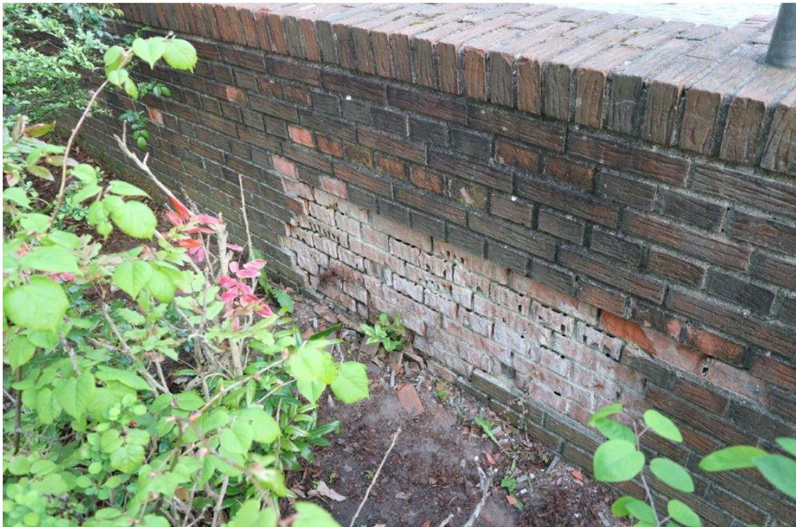
Durchfeuchtung und Frostschaden an der hinteren Wand
