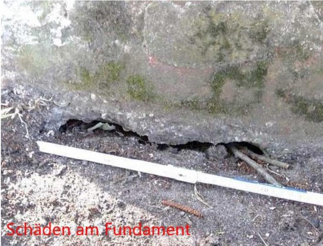
Schäden am Fundament
