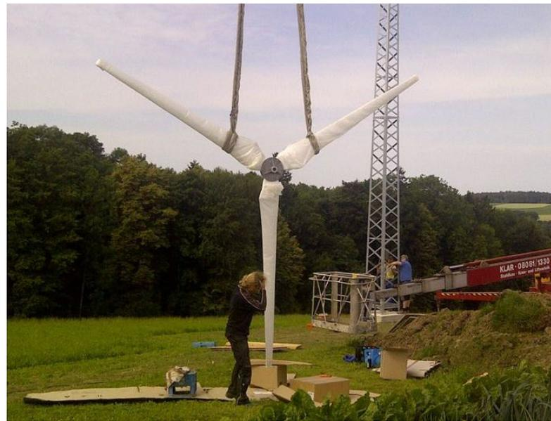
*Abbildung 7:* Vormontierter Rotor
