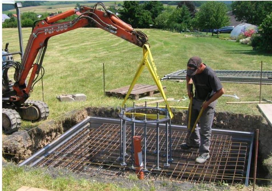
Abbildung 2: Montage des unteren Flansches (Ringanker) im Fundament mit dem innen liegenden Leerrohr für das Kabel zum Generatoranschluss.
