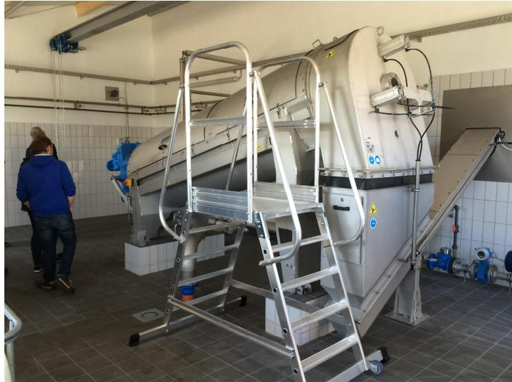
Bild: Schneckenpresse Kläranlage Hohenwestedt
