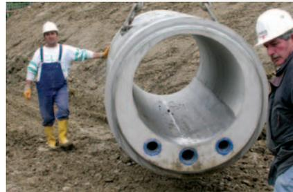
Vorgefertigtes Kanalelement mit eingebautem Wärmetauscher.
