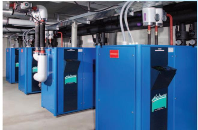
Aus 12-gradigem Abwasser wird 70-gradiges Heizwasser: Die Technik der Wärmepumpe macht es möglich. Foto Satag Thermotechnik
