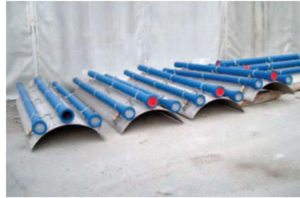
Rinnenwärmetauscher vor dem Einbau in einen Kanal.
