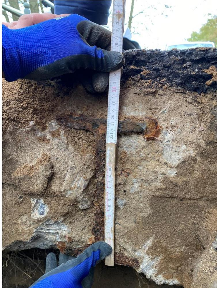
Abbildung 10 Erkundungsschachtung hinter einem Widerlager (Feststellung Walzträger-Abmessungen)
