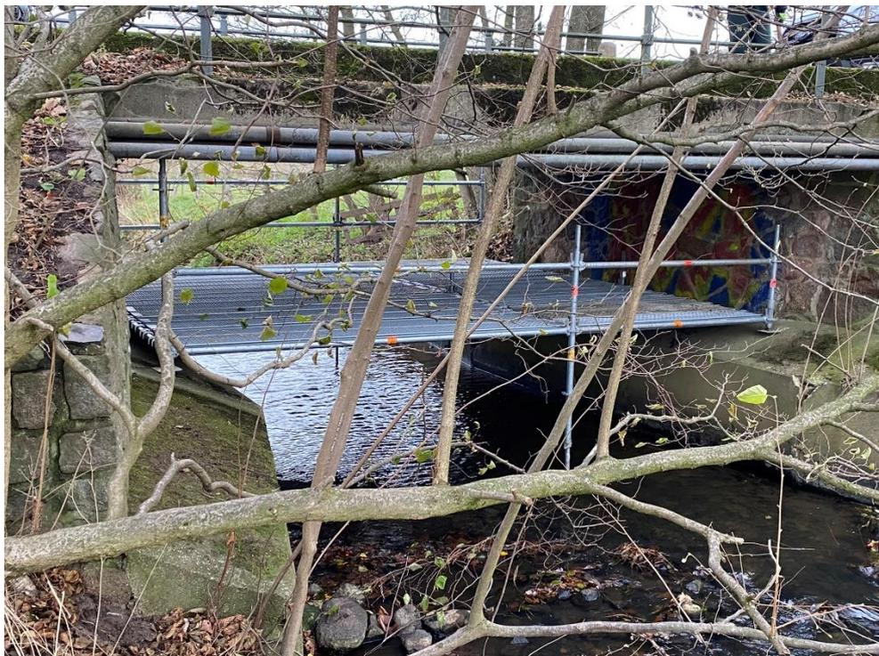
Abbildung 6 Gerüstplattform für Erkundung am Überbau (Bohrkernentnahme, Bewehrungsscan, Feststellung Stahlträgerabmessung)
