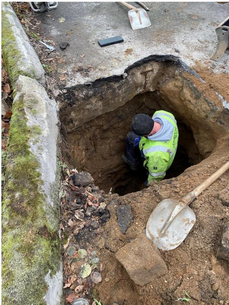
Abbildung 8 Erkundungsschachtung hinter einem Widerlager (Feststellung Wandstärke, Wandbeschaffenheit und Gründungskonstruktion)
