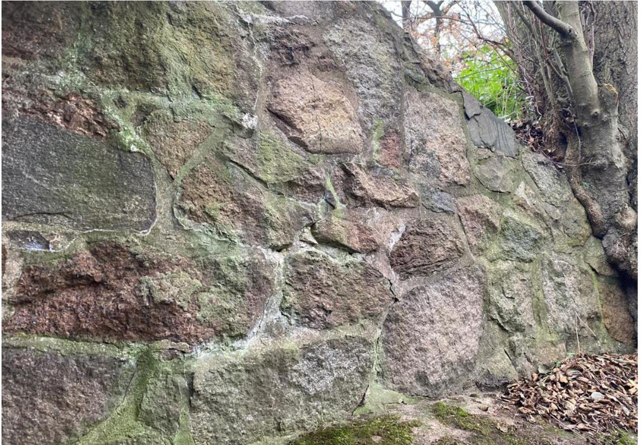
Abbildung 17 Fugenbild des Zyklopenmauerwerk
