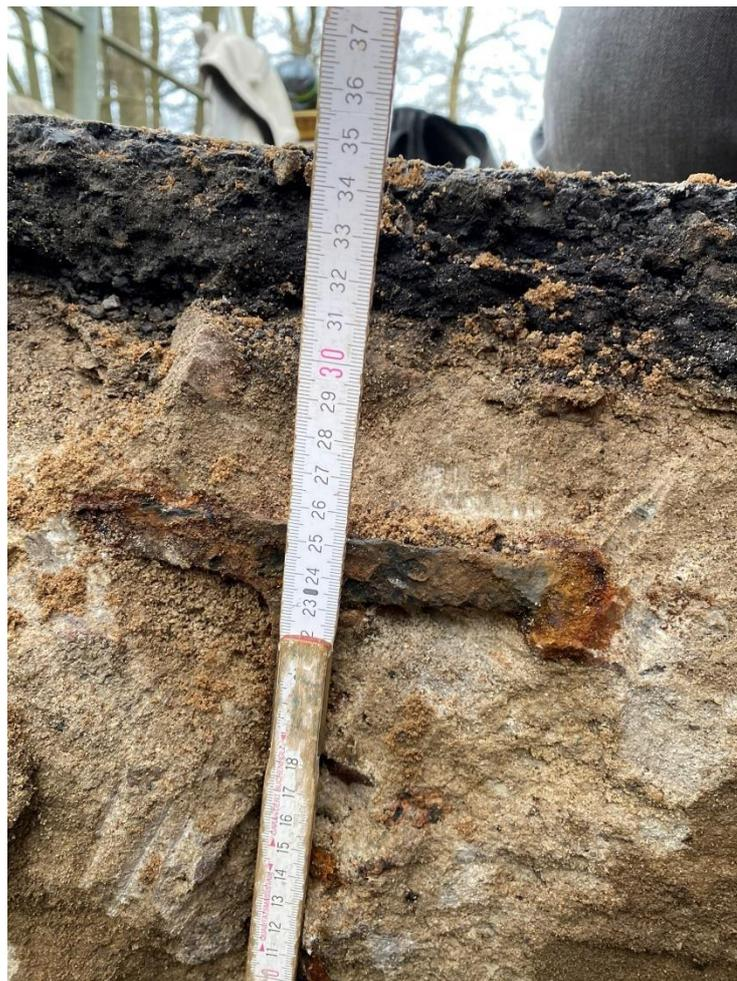
Abbildung 12 Betondeckung (oberhalb) 5cm + Asphalt dicke 3,5cm
