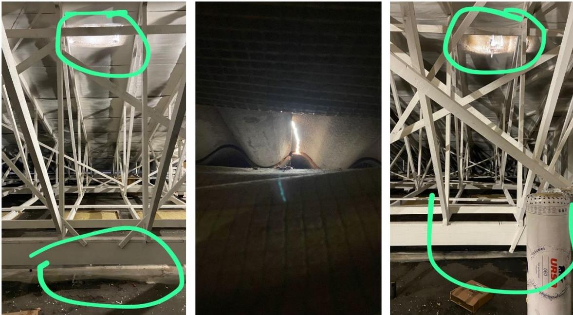
Schäden an den Eternit-Platten und Wasser auf dem Flachdach
