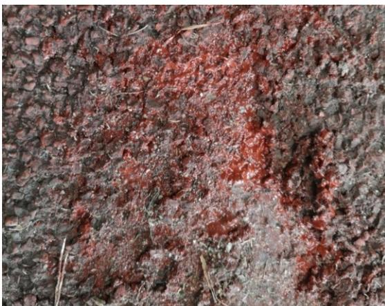
Foto: Belag Laufbahn mit „Schmierfilm“ und Dellenbildung
